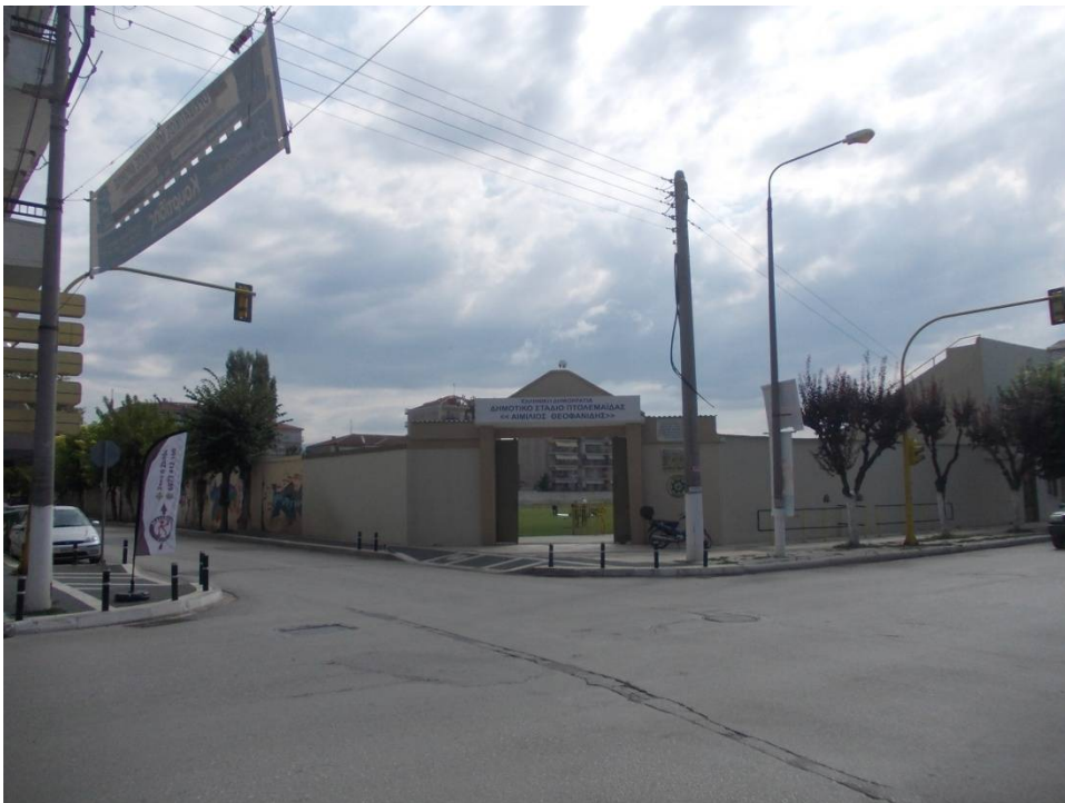
Περιοχή Εθνικού Σταδίου Πτολεμαΐδας
