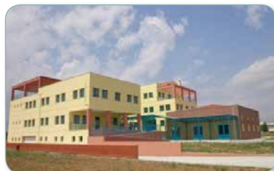
ΔΙΟΙΚΗΤΗΡΙΟ ΠΤΟΛΕΜΑΪΔΑΣ τριώροφο κτίσμα, με εμβαδόν 1.825 τ.μ και χώρο στάθμευσης οχημάτων 145 θέσεων
