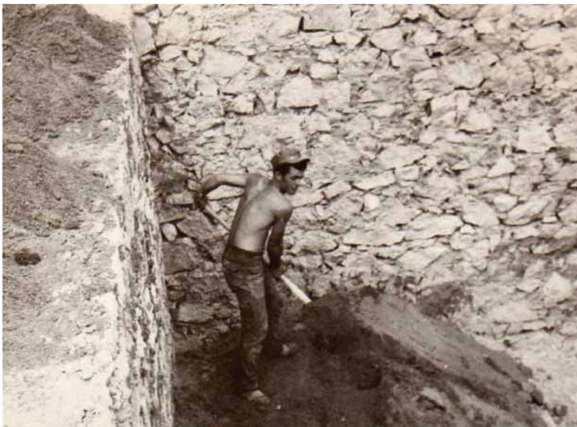
1963 ΕΡΓΑΣΙΕΣ ΚΑΤΑ ΤΗΝ ΚΑΤΑΣΚΕΥΗ ΤΟΥ ΥΔΡΑΓΩΓΕΙΟΥ
