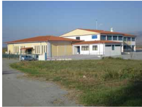
ΔΗΜΟΤΙΚΟ ΣΧΟΛΕΙΟ ΕΤΟΣ ΚΑΤΑΣΚΕΥΗΣ 2004
