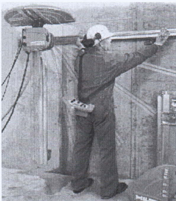
Σχ 2: Κοπή τοίχου με δισκοπρίοιο επί τροχίων καθοδήγησης
