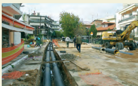
Επέκταση δικτύου Τηλεθέρμανσης
